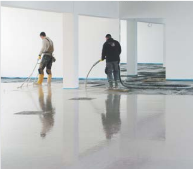
Estricheinbau (inkl. Entlüftung durch Schwabbeln)
